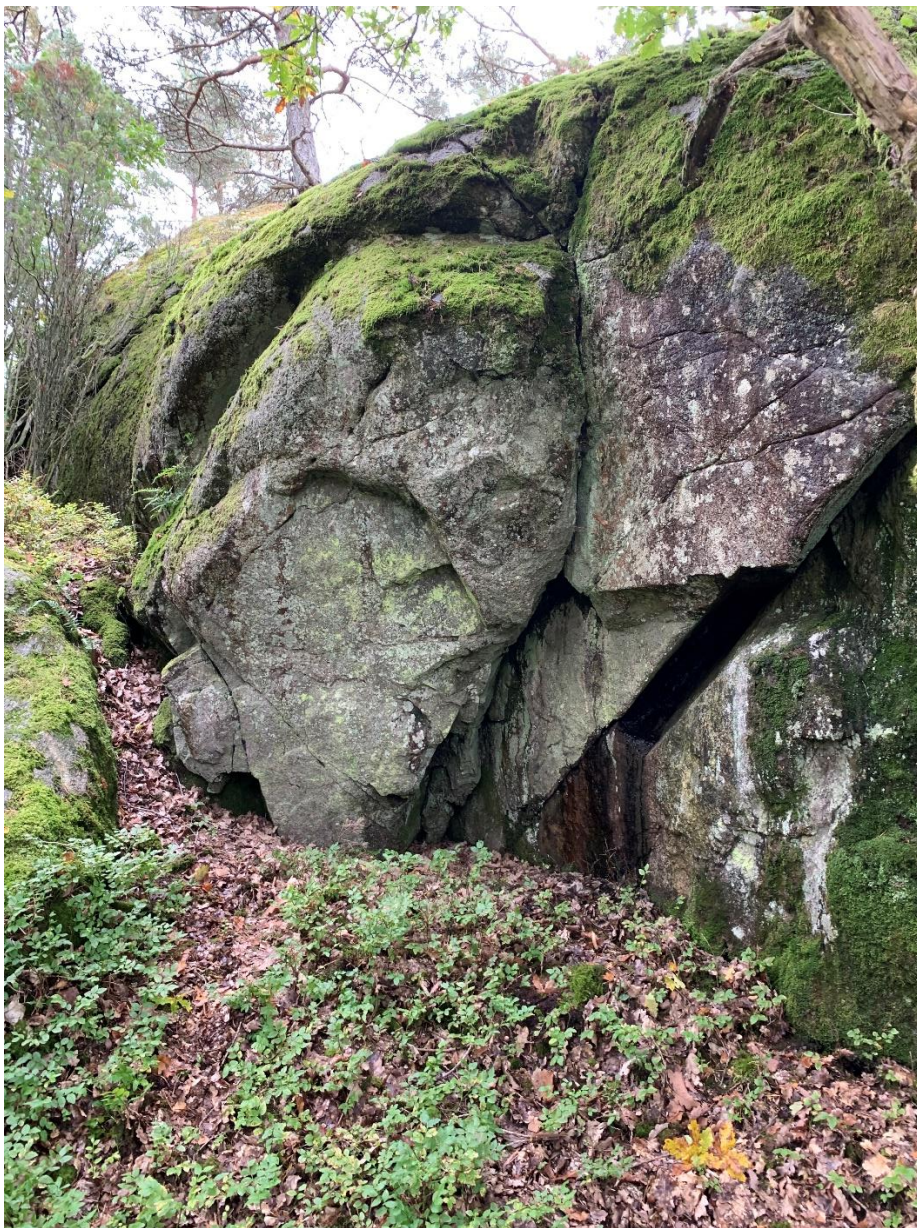
Figur 4 Bergslänt med risk för blockutfall i område 2.
