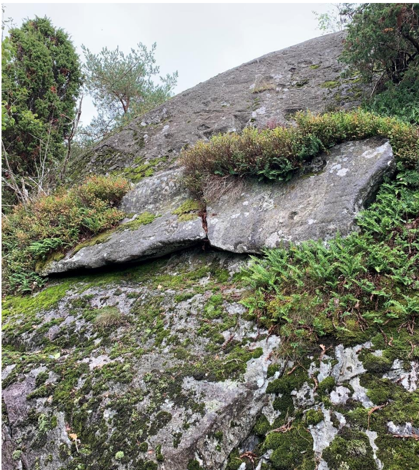
Figur 3 Bergslänt med risk för blockutfall i område 1.
