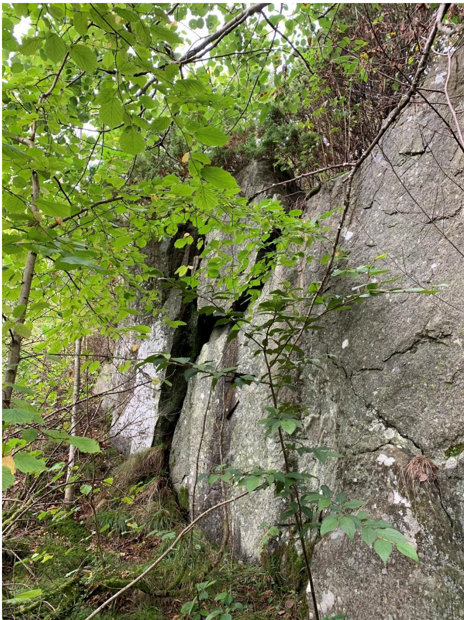
Figur 5 Bergslänt med risk för blockutfall i område 3.
